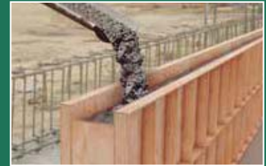
Moldajes y base para laminación.
